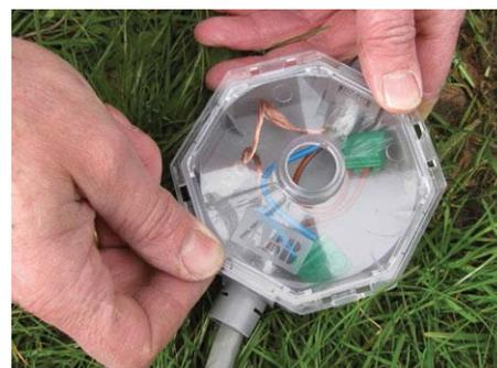
Remettez le couvercle en place et vérifiez si les crochets de fixation du couvercle sont solidement accrochés.
