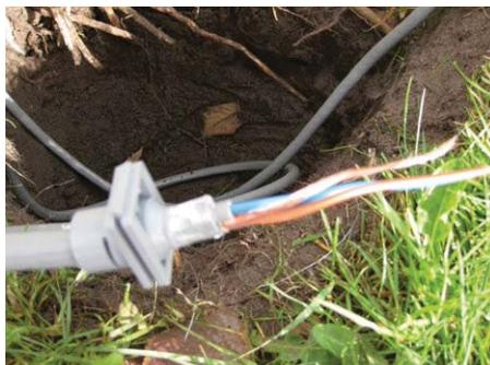
En cas de câbles tressés, utilisez le ruban (fil d'acier ou de cuivre se trouvant sous la tresse d'acier) comme terre et connectez-le à l'aide d'un domino. (Sectionnez le reste de la tresse).
