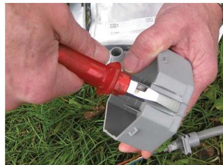
A l'aide d'une pince, brisez les opercules de la boîte de dérivation. Seuls les orifices où les serre-câbles de montage doivent venir s'insérer doivent être percés.
