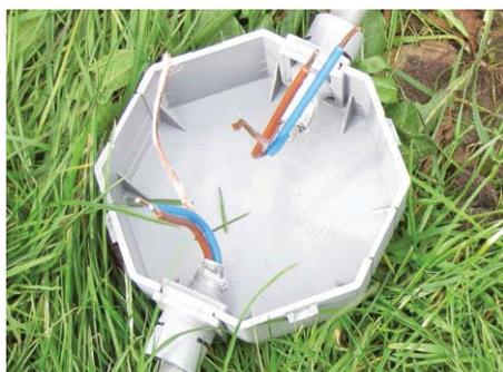
Mettez le câble enfiché dans le serre-câble en place à l'intérieur de la boîte de dérivation et réalisez les branchements.
