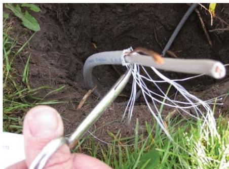
Dénudez la gaine extérieure du câble sur la plus grande longueur pour permettre un raccordement fiable et de qualité (recommandation : 10 cm min.).
